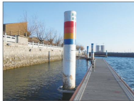
图 17 浮桥柱桩的直涂式警戒潮位标志物
