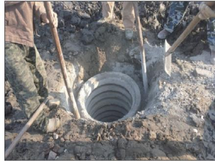
图13 改进后的直观式(水泥管)标志物底座
