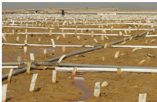
图4 滤管布设施工现场
