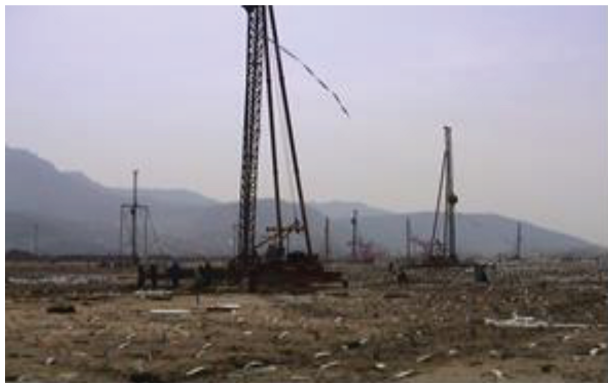
图 2 排水板打设施工现场
