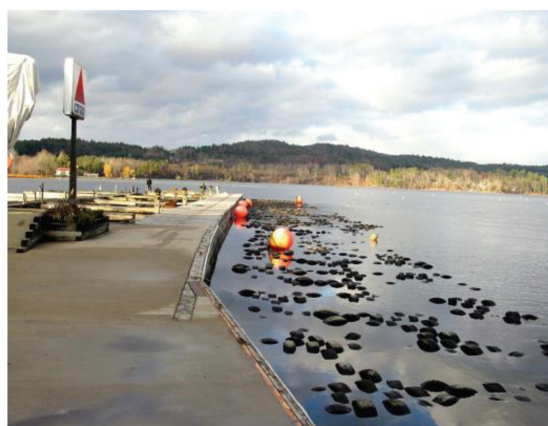
(b)隔栏工程
